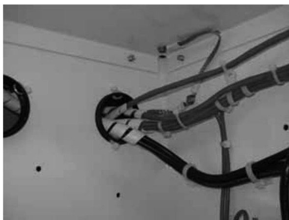
图 2.28 - 120 伏电缆和 XIO 电缆穿过上侧开口
